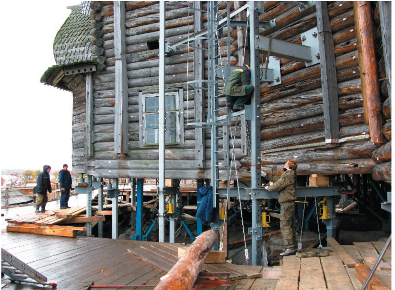
фото 17. Заключительная стадия разборки. Общий вид. Осталось снять 2 венца по периметру.
