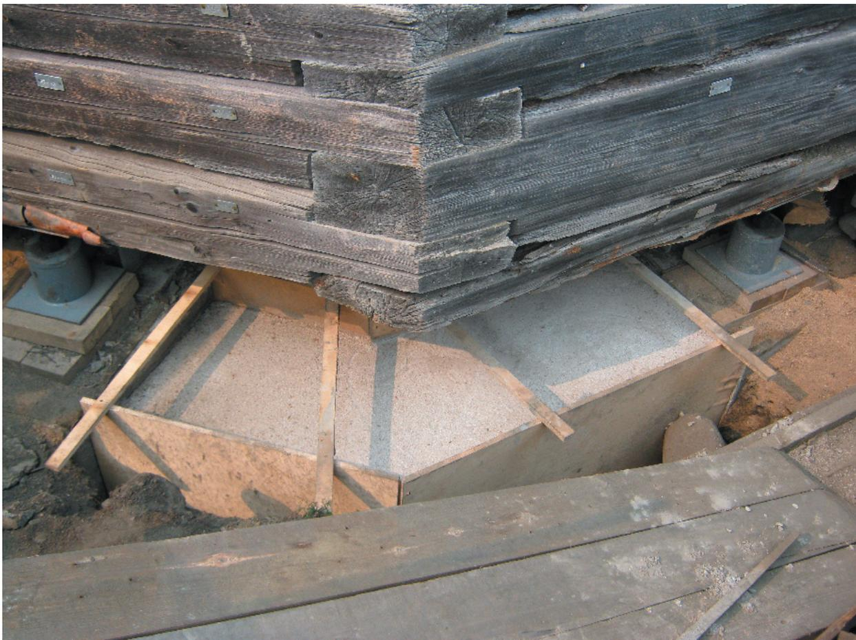
фото 3. Залитый фундамент в опалубке, после 7-ми дневной выдержки снимается опалубка
