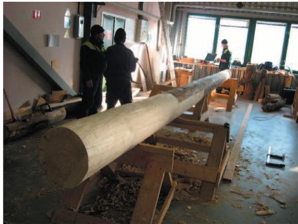
фото 16. Вставка из новой древесины на элемент трапезной - сохранение поврежденного элемента
