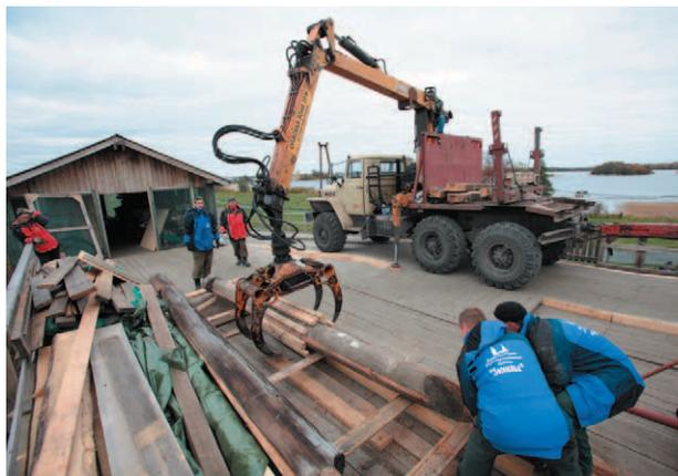
фото 26. Погрузка элементов с использованием бандажа для транспортировки в Реставрационный комплекс
