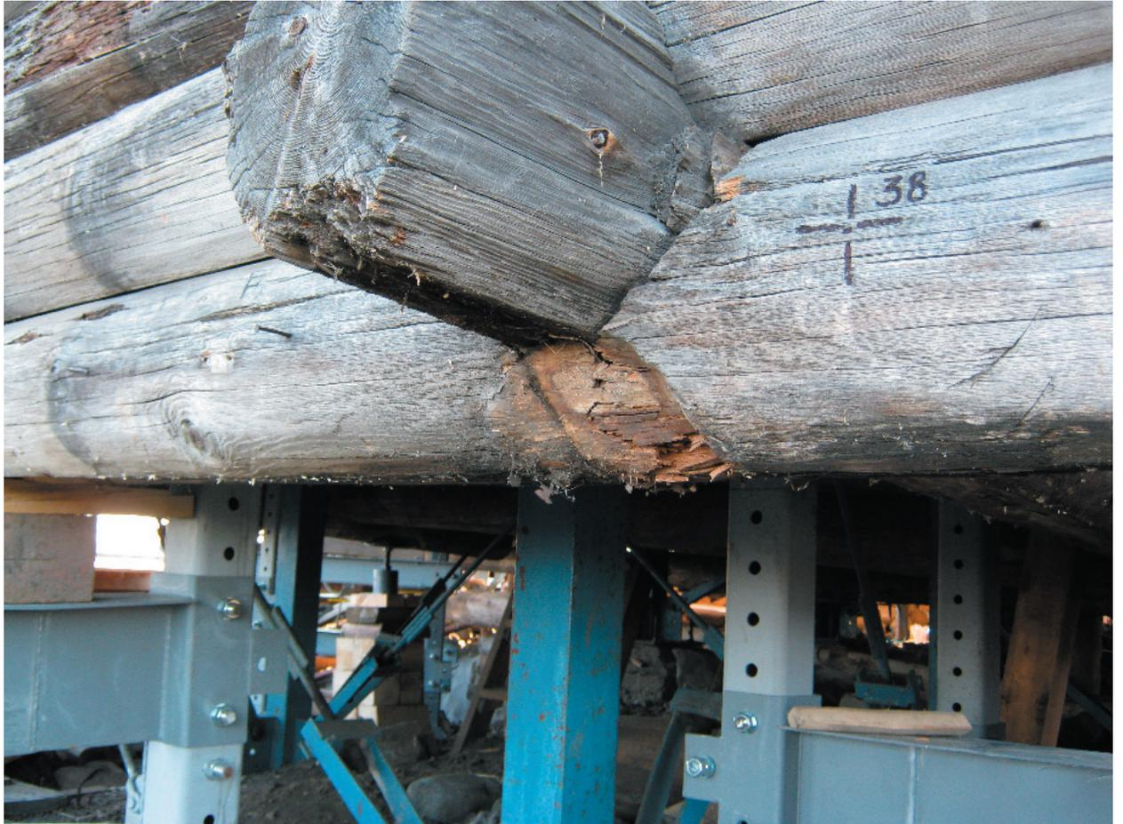
фото 11. Скрытые в чашах дефекты сруба - полностью разрушенная чаша бревна
