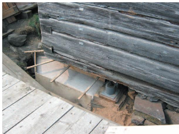
фото 32. Работа небольшими захватками по устройству нижней части фундамента
