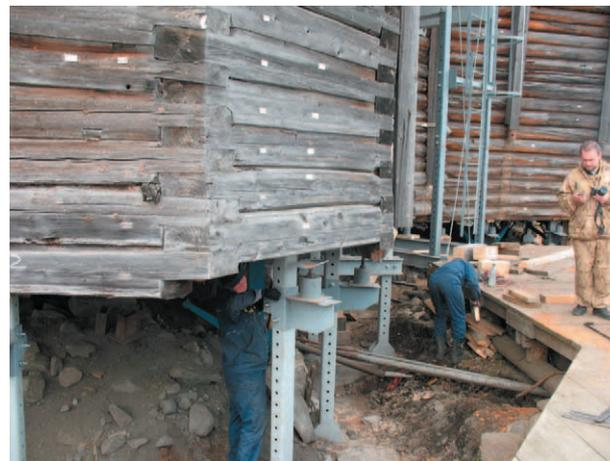
фото 25. Фиксация стен после снятия элемента
