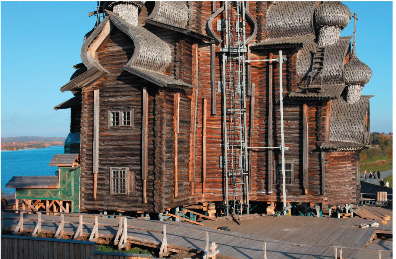
фото 20. Общий вид рабочей площадки, конструкций лифтинга и части разобранного технологического пояса.
