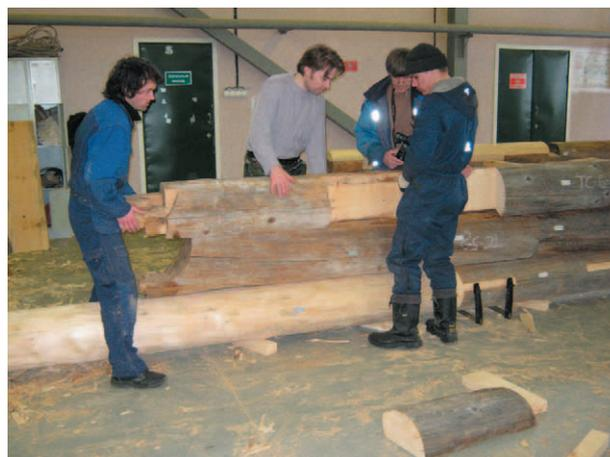
фото 19. Реставрация бревен трапезной с учетом положения соседних (верхних и нижних) элементов
