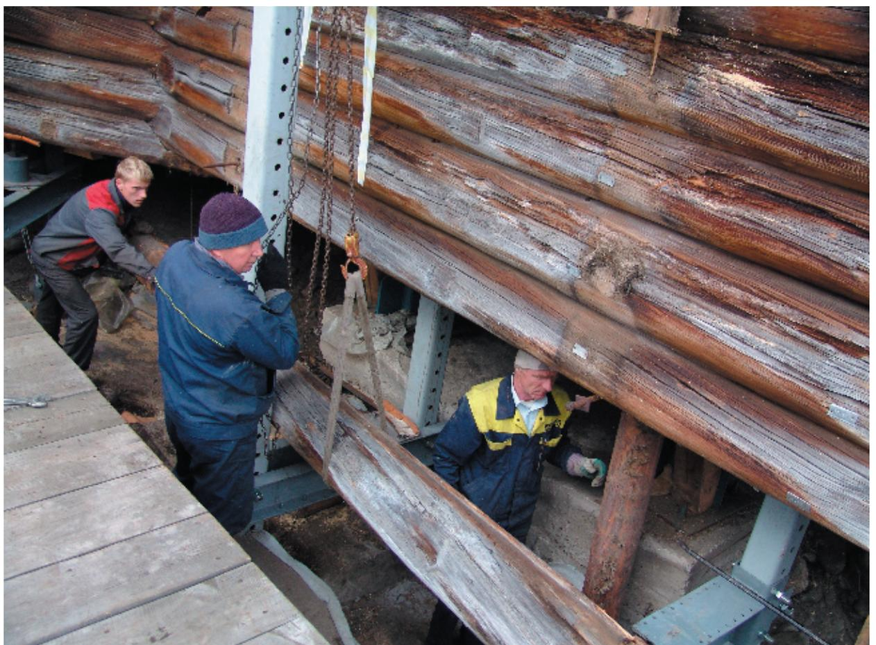
фото 6. Снятие бревен с особой осторожностью. Перемещение бревен на настил-эстакаду.
