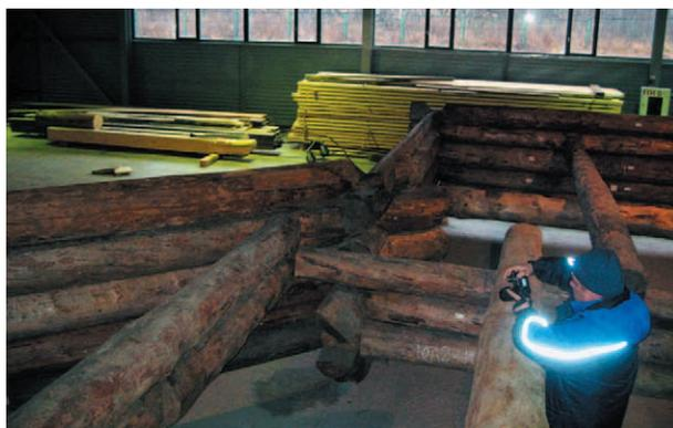
фото 31. Установка балок церкви в исторические гнезда - определение первоначальной геометрии сруба церкви на XVIII век
