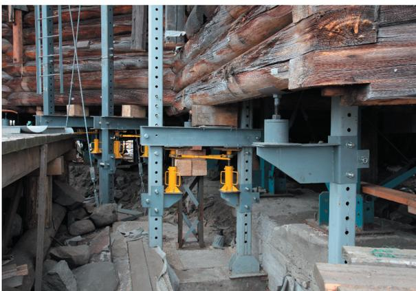
фото 12. Подвижные подъемные механизмы системы лифтинга - консоли, балки, два вида домкратов
