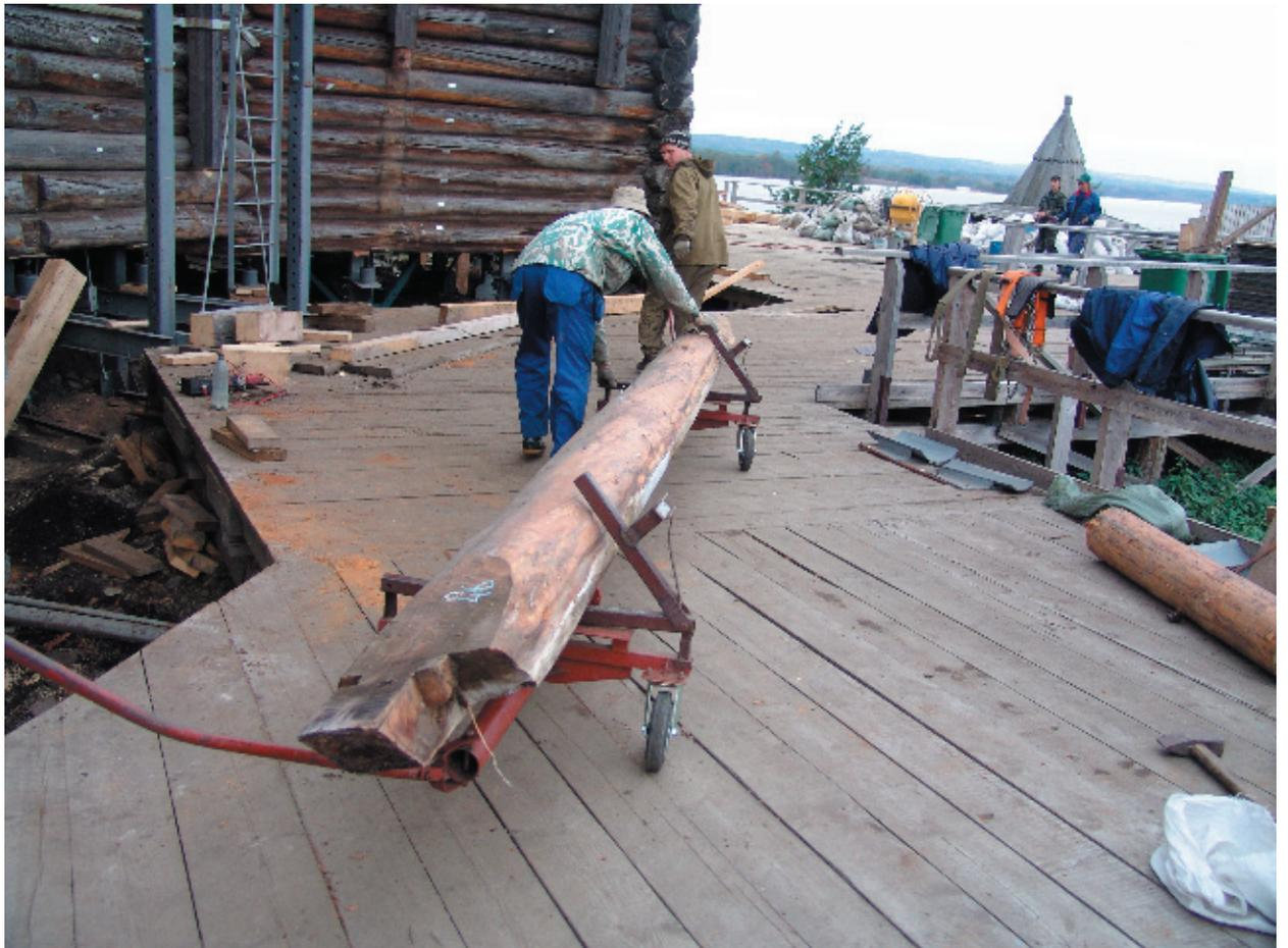
фото 7. Транспортировка по настилу-эстакаде на специальной тележке до навеса временного хранения
