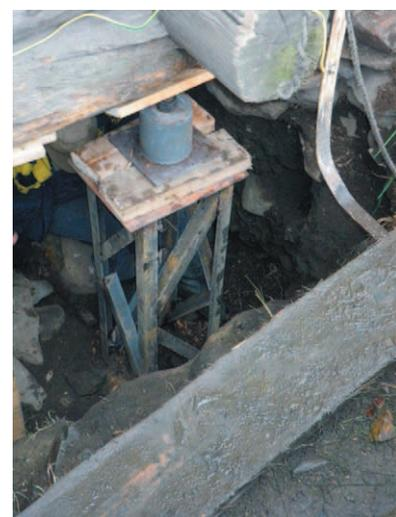
фото 34. Дополнительная опора при заливке фундамента
