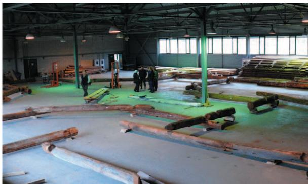
фото 30. Начало сборки разобранного пояса в Реставрационном комплексе
