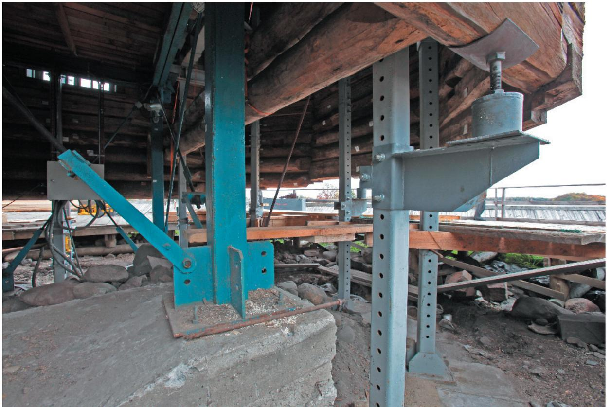
фото 12. Последовательная разборка сруба снизу-вверх. Регулярные наблюдения показывают устойчивое положение сруба.
