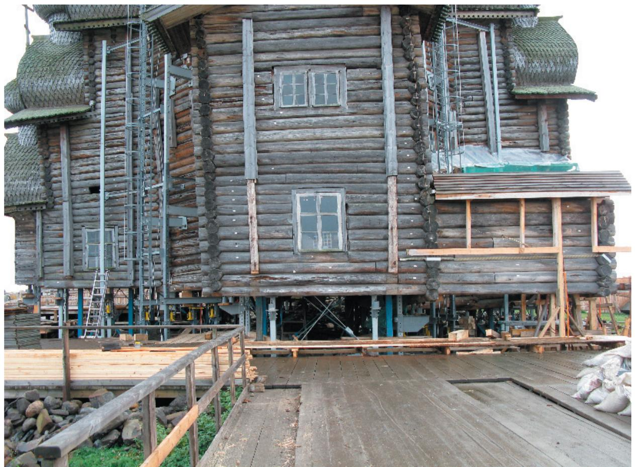
фото 18. Заключительная стадия разборки. Общий вид. Осталось снять 1 венец по периметру.
