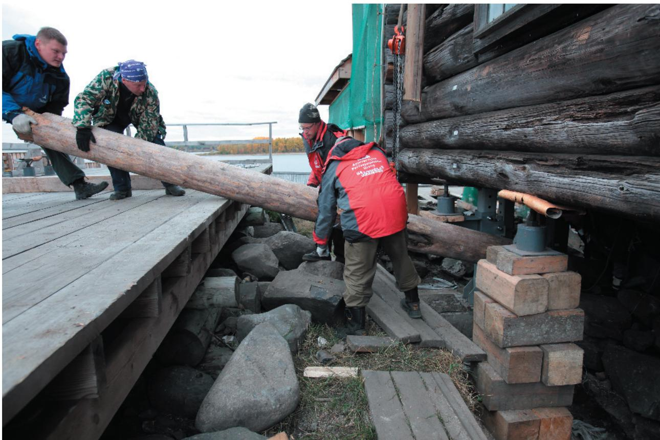
фото 14. Демонтаж балок, в том числе длиной 12 метров, не вызвал затруднений
