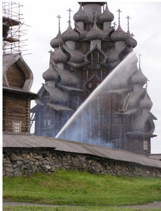
фото 1. Проверка системы пожаротушения Кижского погоста
