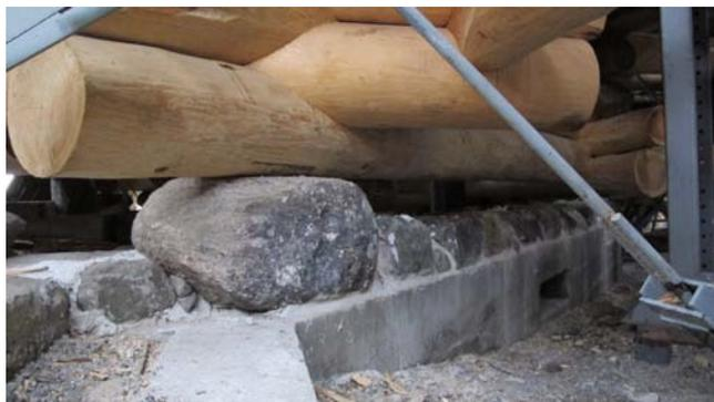
фото 12. Валуны под углами сруба и каменная забирка на известковом растворе между валунами
