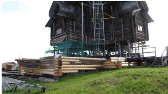
фото 9. Сборка отреставрированного подклета на фундаменте
