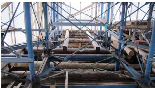
фото 11. Корректировка положения горизонтальных металлических связей силового каркаса
