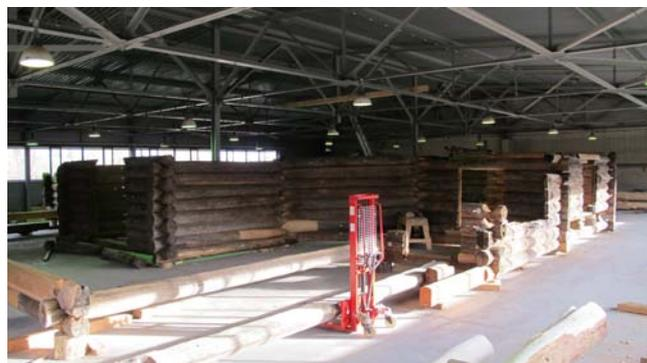
фото 14. Предварительная сборка объема VI-го пояса в Реставрационном комплексе
