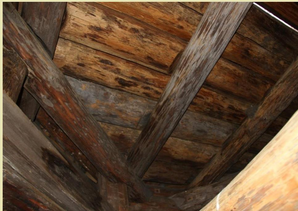
Конструкция перекрытия в виде настила из плах
