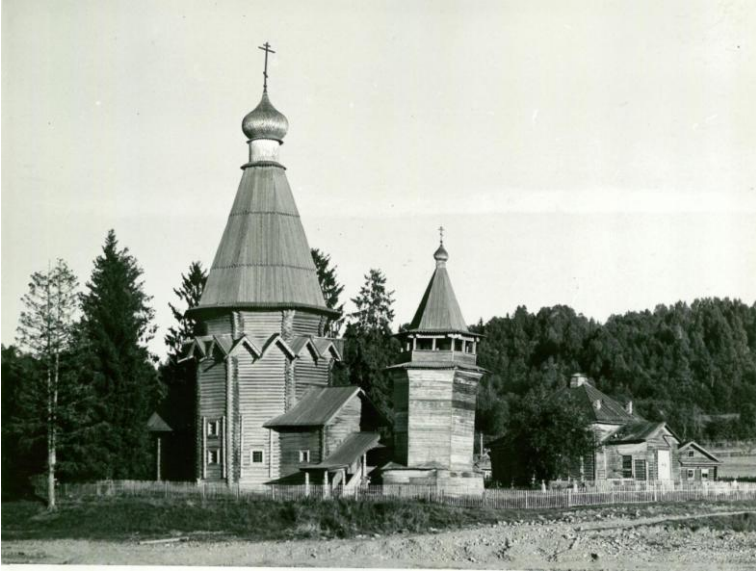
Рис. 2. Церковь Свт. Николая Чудотворца. Фото В. Коренькова, 1980 г. НА Комитета по сохранению культурного наследия Ленинградской области.
